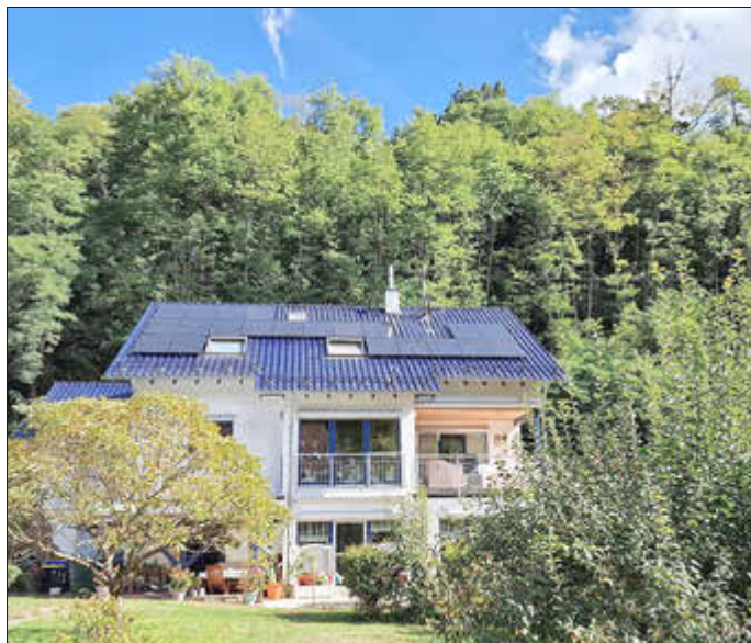
Beispiel PV Anlage Dach
