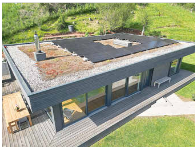
Beispiel PV Anlage Flachdach
